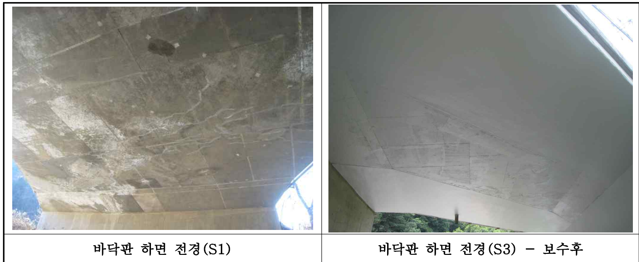
【사진 1.3.2】 바닥판하면 전경
