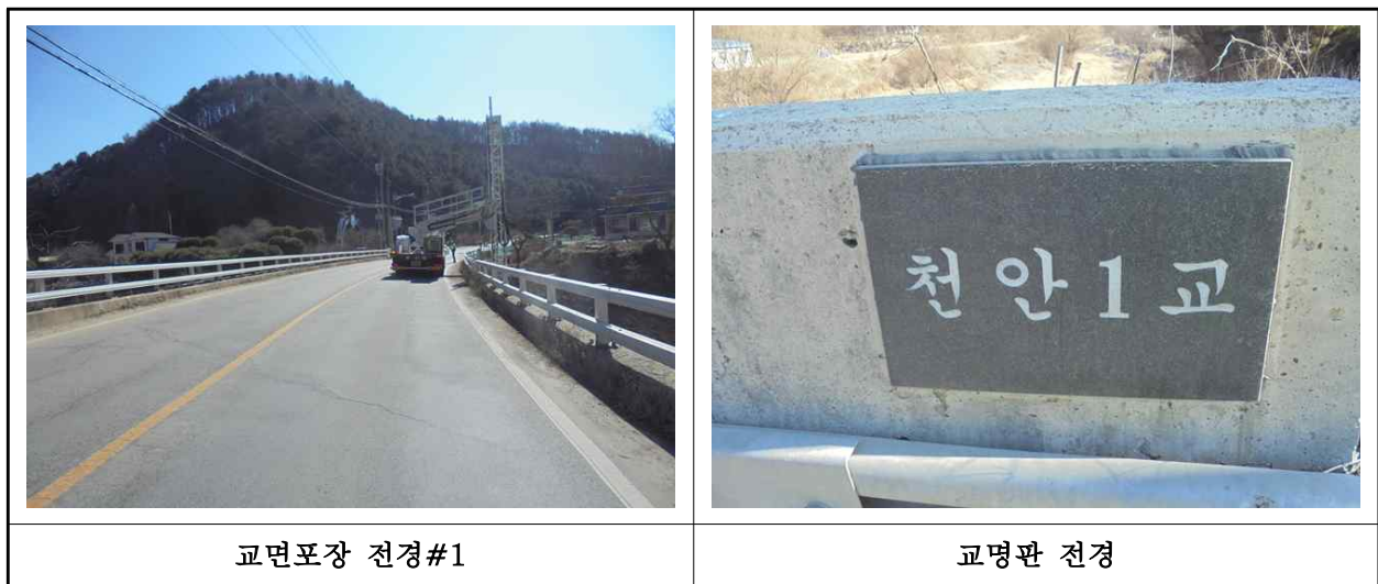
【사진 1.3.8】 교면포장 전경
