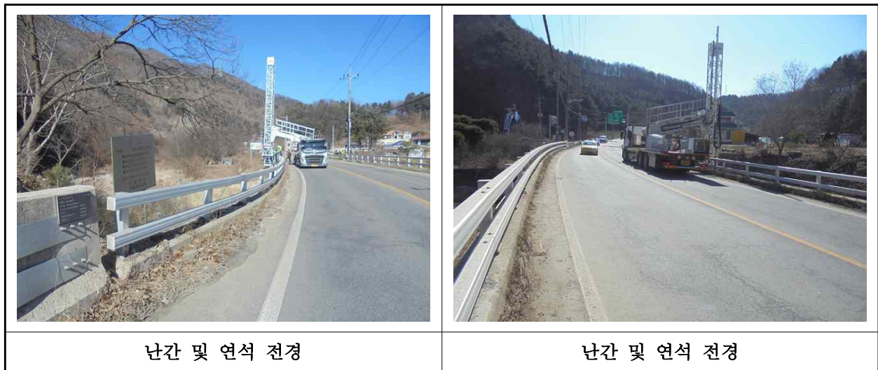
【사진 1.3.12】 난간 및 연석 전경
