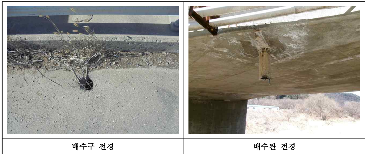
【사진 1.3.10】 배수시설 전경
